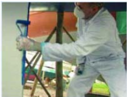
Należy nałożyć dodatkową warstwę na ostrych krawędziach
